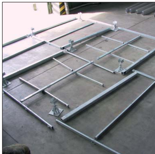
Abbildung 19 Stützen und Träger vorpositioniert
