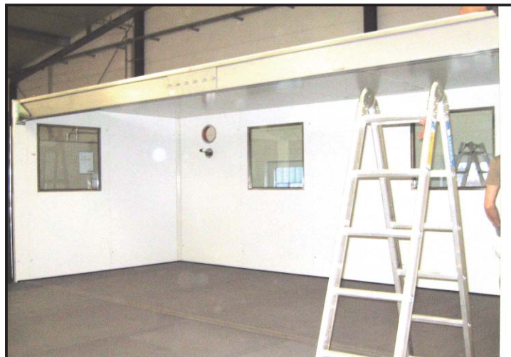
Abbildung 54 erstes Dachfeld geschlossen
