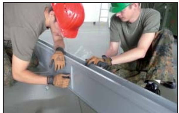
Abbildung 48 Zusammensetzen Dachträger
