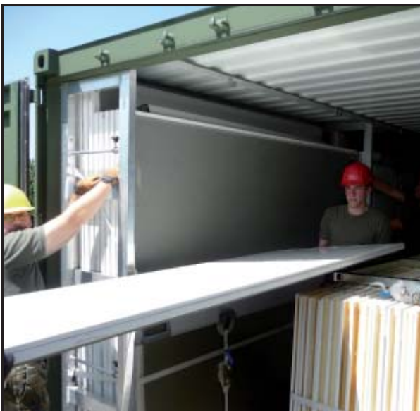
Abbildung 30 Entnahme der Elemente
