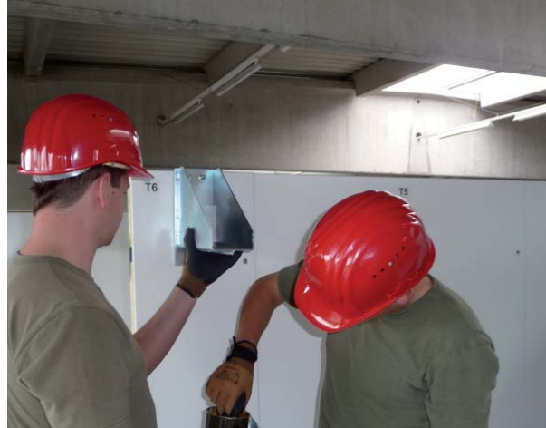
Abbildung 64 Dachschuh Trennwand
