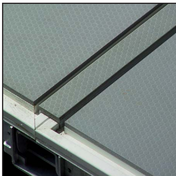
Abbildung 36 montierte Verbindungsleiste
