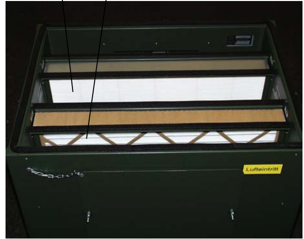
(Abb.10) Zuluftfilterkasten ohne Deckel
