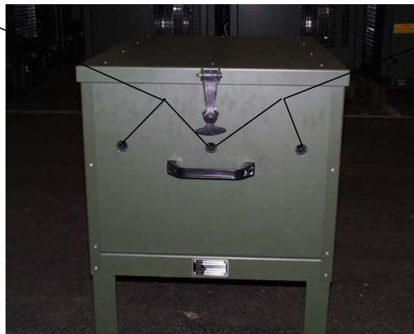
(Abb.11) Zuluftfilterkasten Seitenansicht Druckmessstellen
