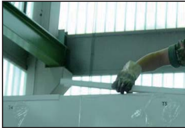
Abbildung 67 oberes U-Profil aufstecken
