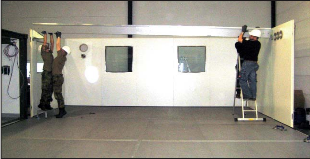
Abbildung 49 Dachträger Feld 1 einsetzen
