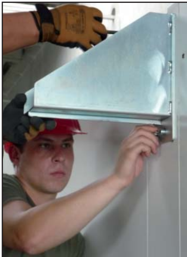
Abbildung 46 Montage Dachsuhle
