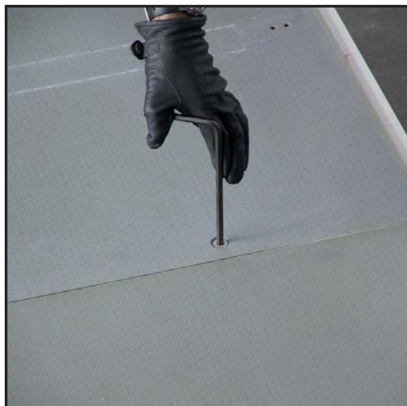
Abbildung 34 Betätigen der Verschlüsse
