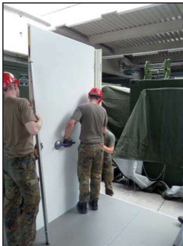
Abbildung 41 Ansetzen der Wand
