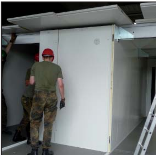
Abbildung 71 Dachplatten auf dem Dach
