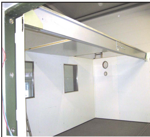
Abbildung 50 Dachträger montiert
