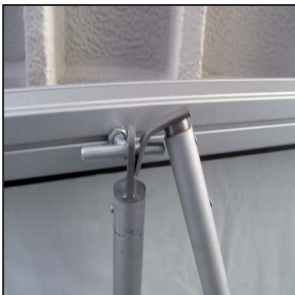
Abbildung 111 Anbindung Türgestänge
