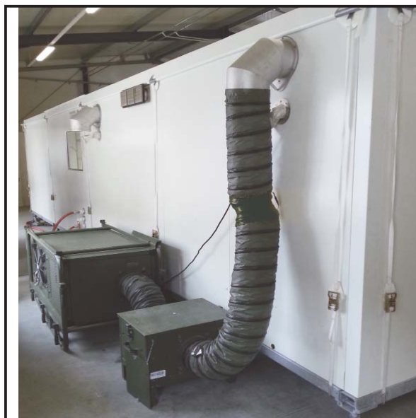
Abbildung 90 Klimaanlage ZKB 15 mit Filter
