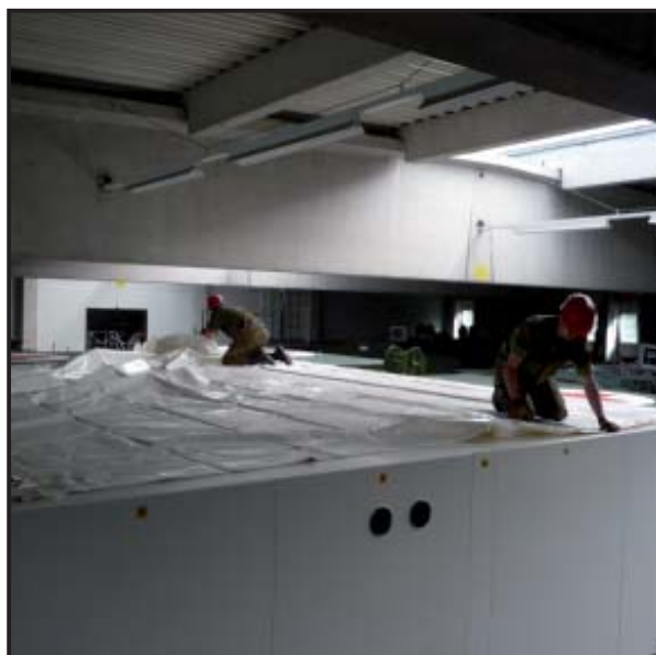
Abbildung 76 Dachplane Ecke ansetzen
