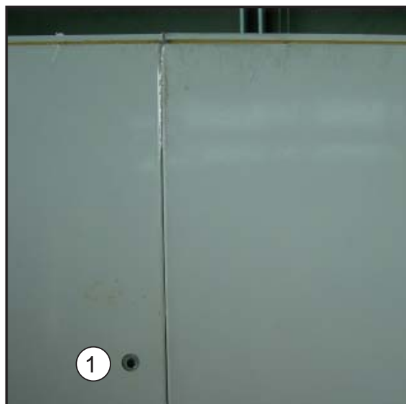
Abbildung 44 Zwei verbundene Wandelemente
