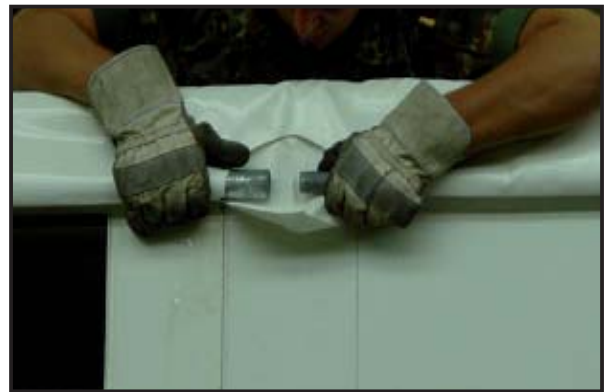
Abbildung 78 Rohre verbinden
