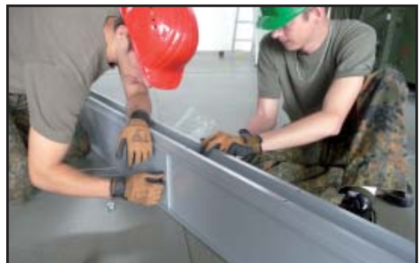
Abbildung 48 Zusammensetzen Dachträger
