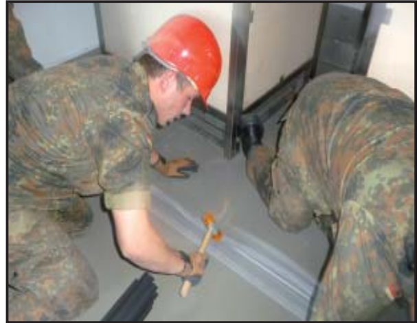
Abbildung 88 Abdeckprofil Montage
