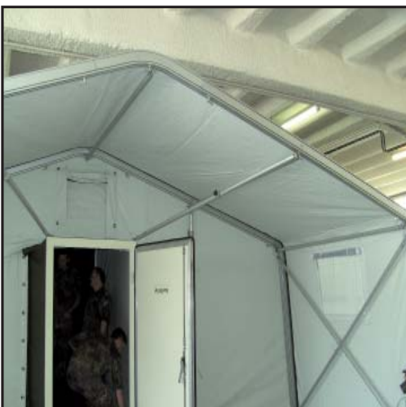
Abbildung 110 Zugangstür Schleuse
