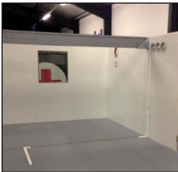
Abbildung 60 U-Profil auf dem Boden
