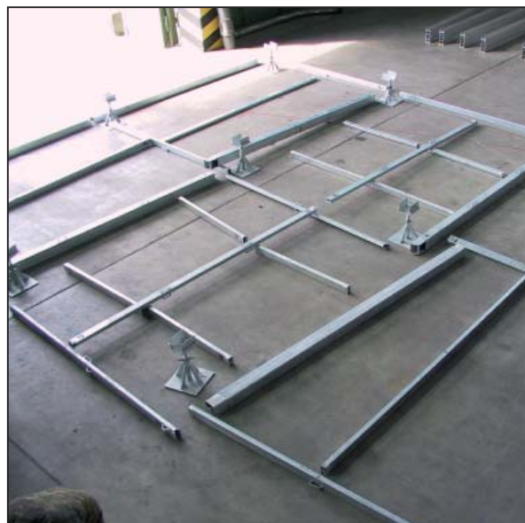
Abbildung 19 Stützen und Träger vorpositioniert
