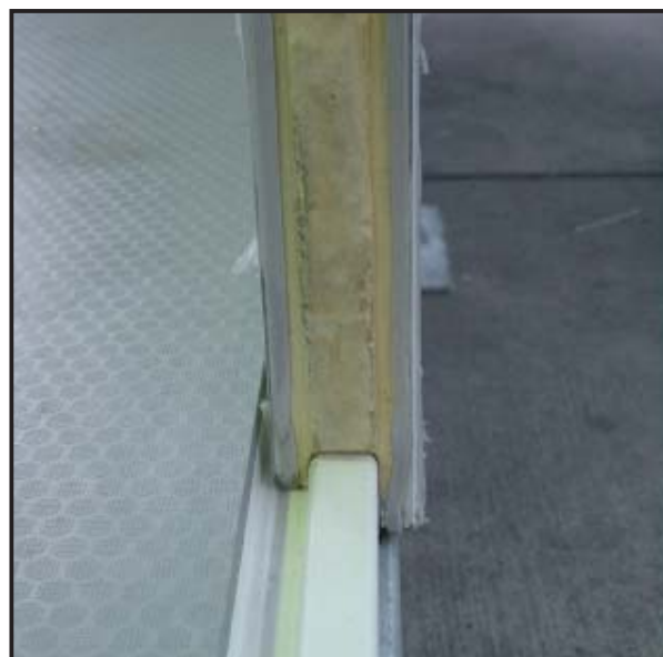
Abbildung 42 Verbindung Boden-Wand
