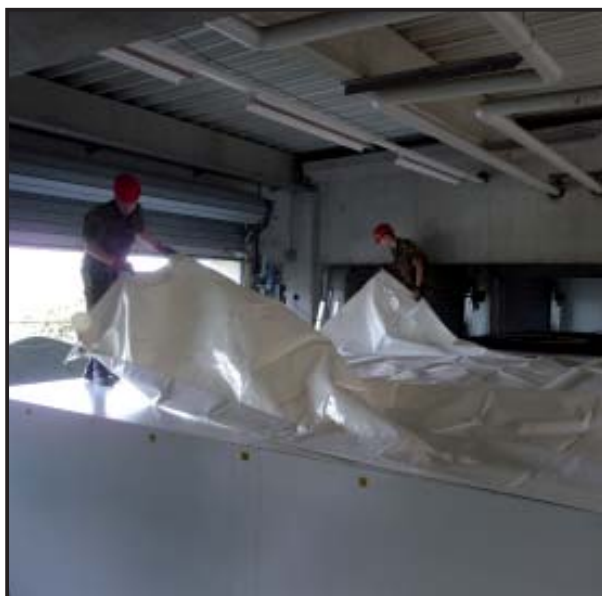
Abbildung 75 Dachplane ausbreiten
