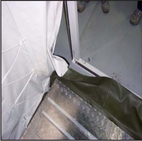
Abbildung 112 Anbindung Türrahmen
