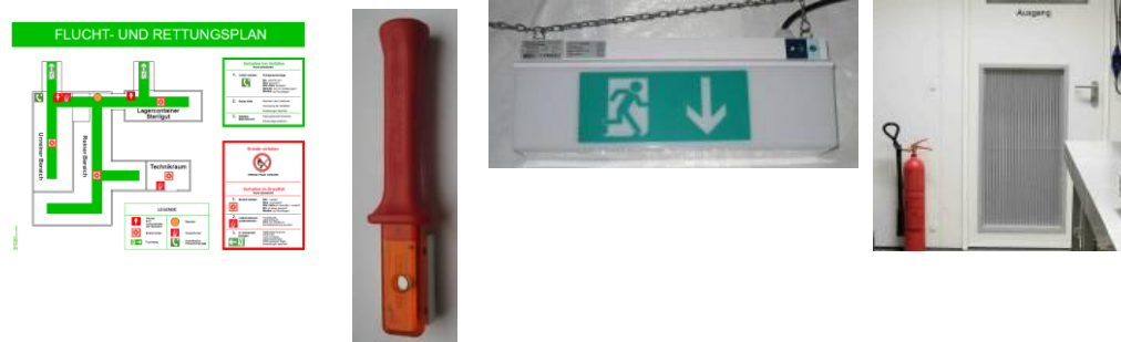
Abb. 7: Flucht- und Rettungsplan, Rettungsmesser, Fluchtwegkennzeichnung, Feuerlöscher
