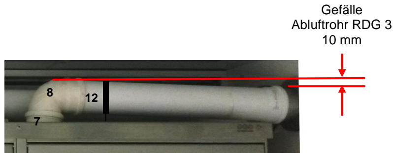
Abb. 12: Montage Abluftrohres Miele rechts (RDG 3)
