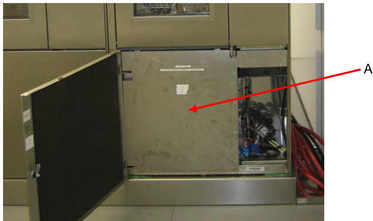
Abb. 4: RDG Miele, Schutzverkleidung Elektroschaltkasten (unreiner Bereich)
