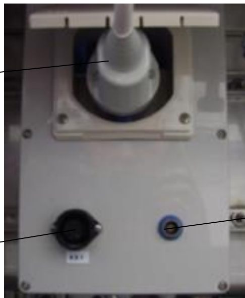
Abb. 2: Elektroanschluss und Datenleitung Rückseite Waschtisch
