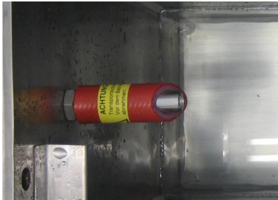
Abb. 5: Draufsicht: Transportsicherung am Schwimmerschalter des Abwassertanks
