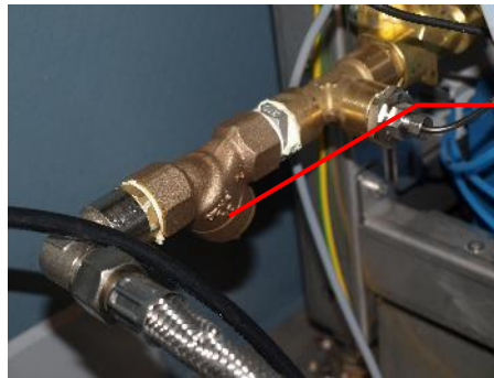
Abb. 22: Schmutzfänger Kühlwasser WRP R09 Rückseite VARIOKLAV® ECO 300 HC
