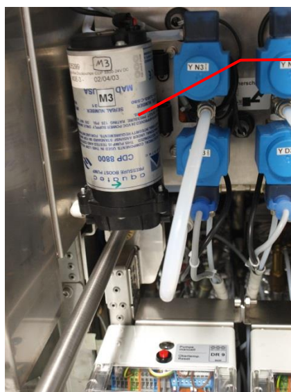
Abb. 20: Speisewasserpumpe M3
