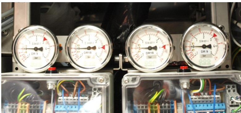
Abb. 16: Manometer DR18 Wartungsseite im Technikraum
