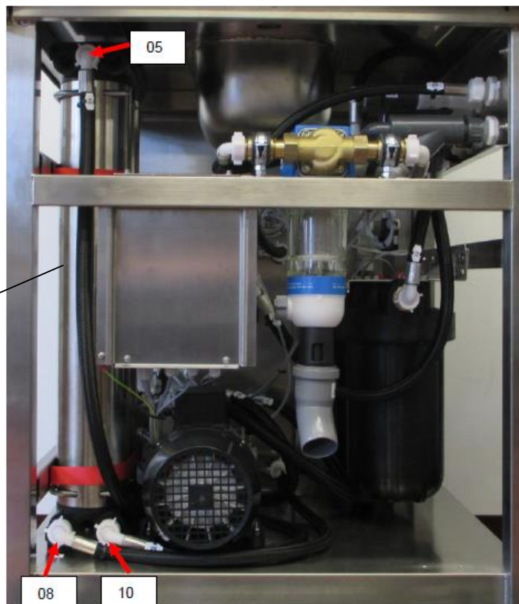
Abb. 4: Rückansicht Waschtisch mit RO-Modulblock k
