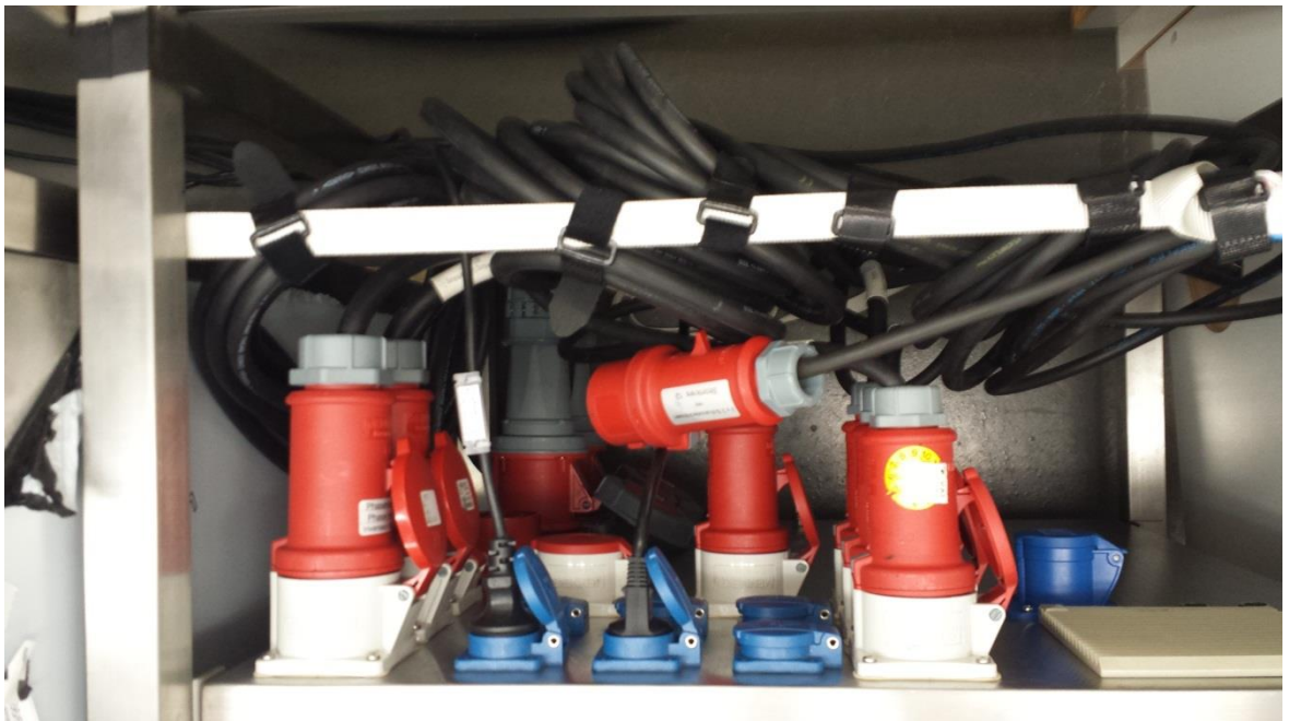
Abb. 9: Längenausgleich der Kabel
