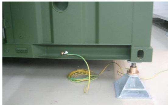
Abb. 12: Schutzleiter mit Erdungsschraube am CLS und am Container 2x4 StE
