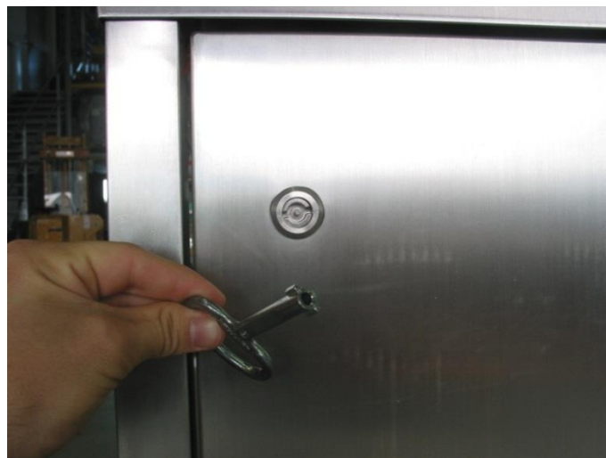
Abb. 1: Schlüssel zum Öffnen des Hauptverteilers
