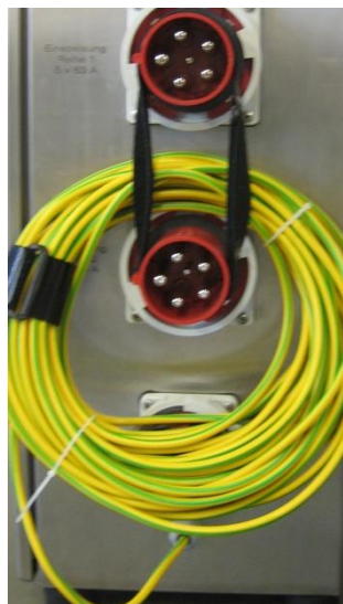
Abb. 8: Befestigung der Schutzleiter am Hauptverteiler EL
