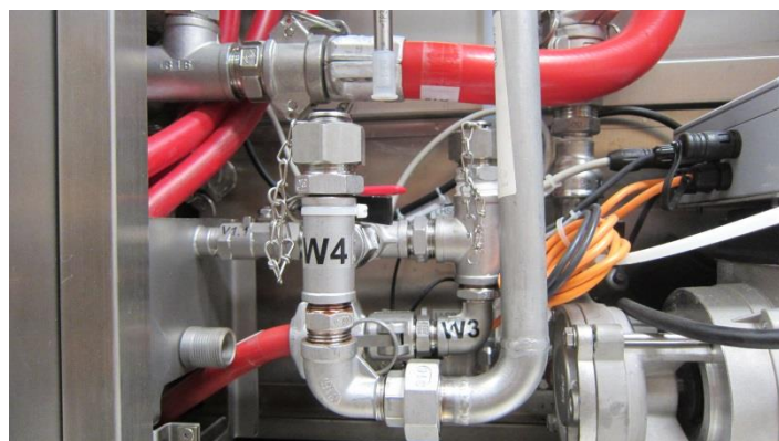
Abb. 3: Detail: Anschlüsse W3 und W4
