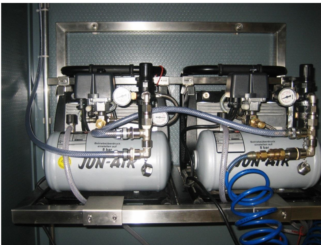
Abb. 1: Wandhalterung mit Druckluftkompressoren
