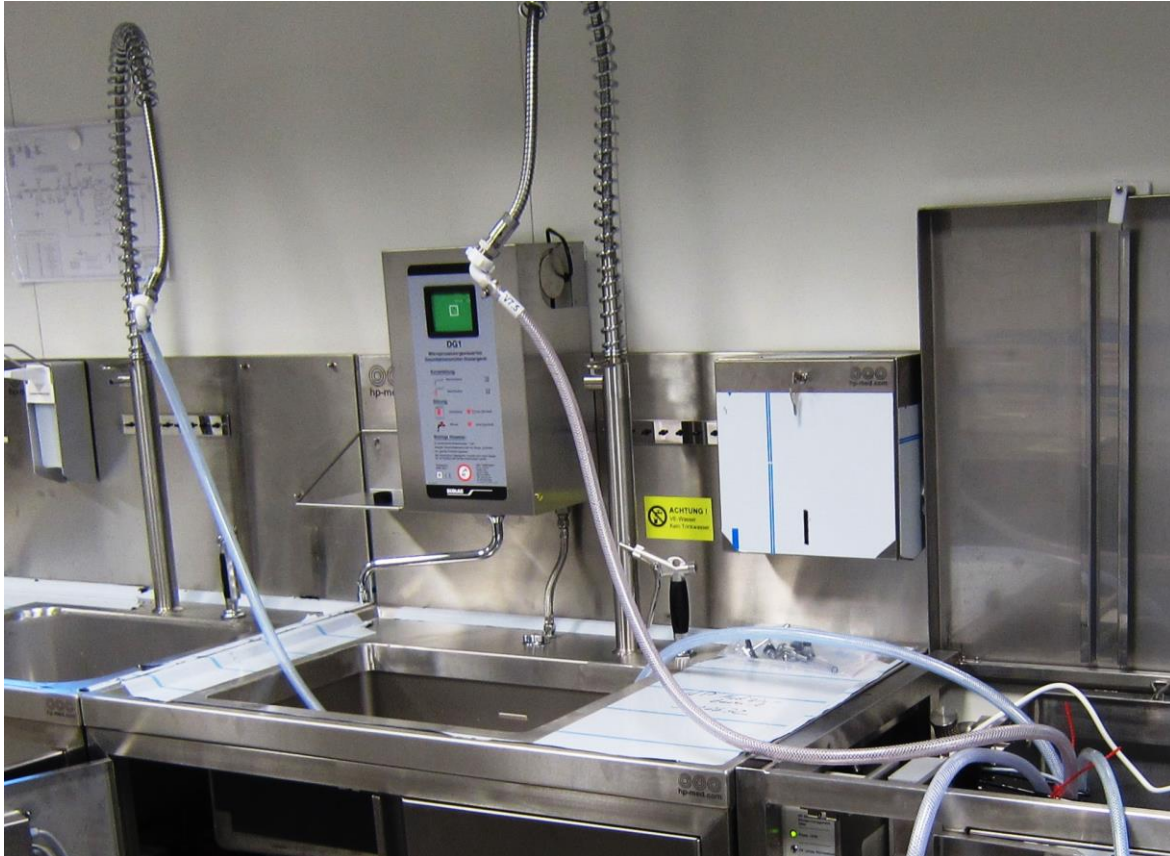
Abb. 10: Desinfektionskreislauf 6, Schlauchpendelbrausen mit Adaptern
