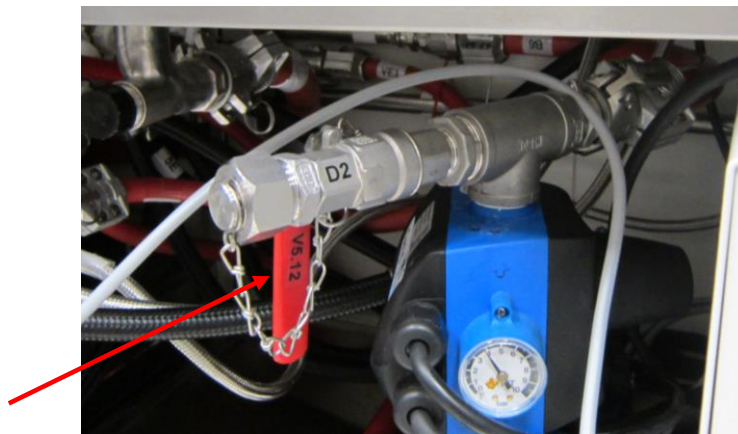
Abb. 16: V5.12 an der Permeatpumpe P5.3
