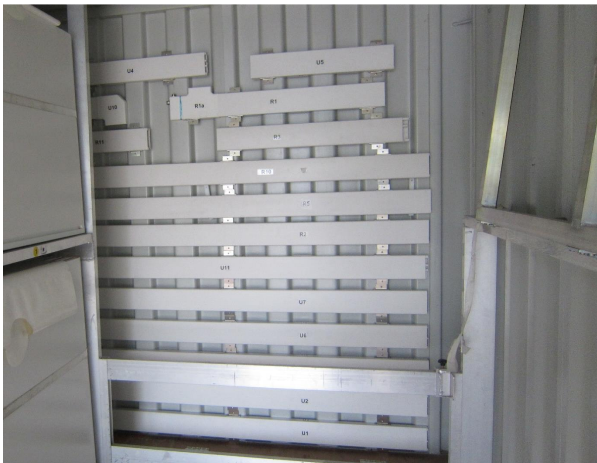
Abb. 1: Platzierung der Kabelkanäle an der Rückwand des CTZ
