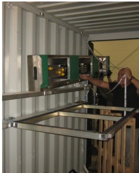
Abb. 5: Einbringen von Teilstück 1 des Versorgungssockels
