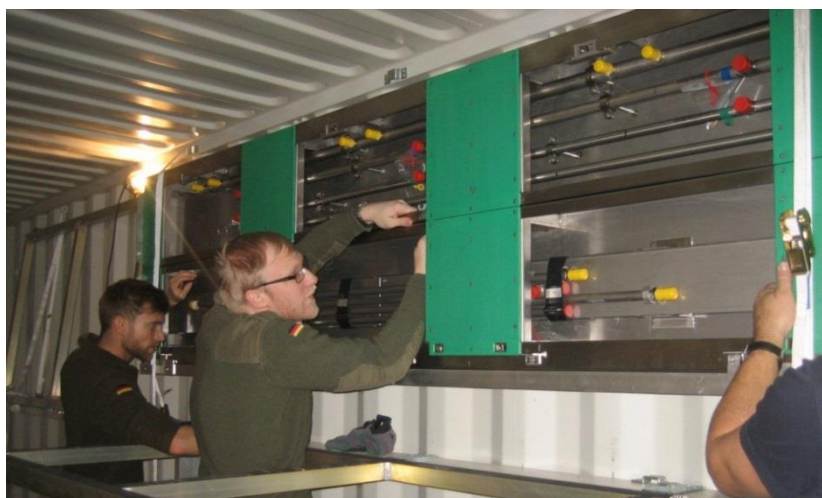
Abb. 6: Verschrauben der beiden Teilstücke des Versorgungssockels
