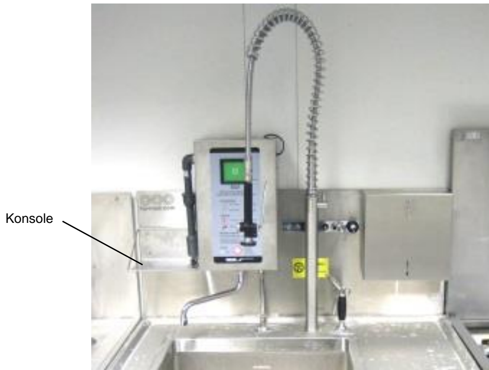
Abb. 16: Dosiergerät an der Rückwand des Spülschranks montiert
