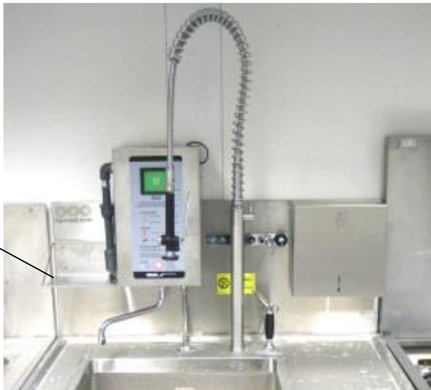
Abb. 14: Dosiergerät an der Rückwand montiert
