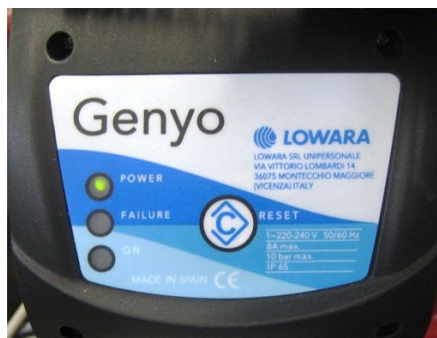
Abb. 7: Elektronische Pumpensteuerung der Permeatpumpe P5.3
