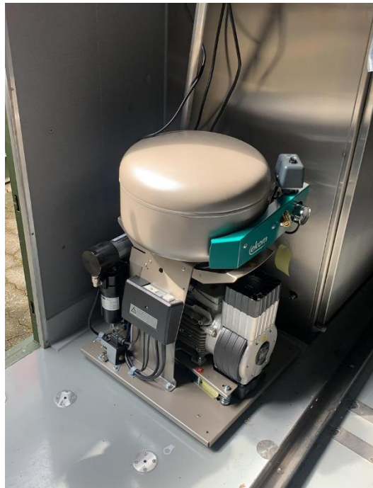
Abb. 6: Druckluftkompressor positioniert
