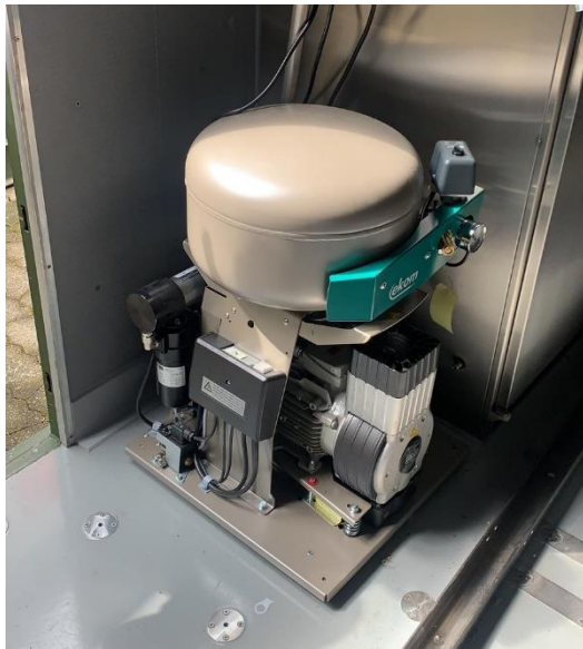
Abb. 1: Druckluftkompressor Einbausituation
