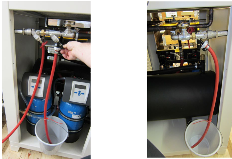
Abb. 3: Ablassen von Wasser an den Spülventilen (44) und (50)
