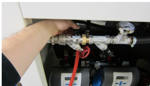
Abb. 4: Anschluss des Druckluftschlauchs an Spülventil (42)
