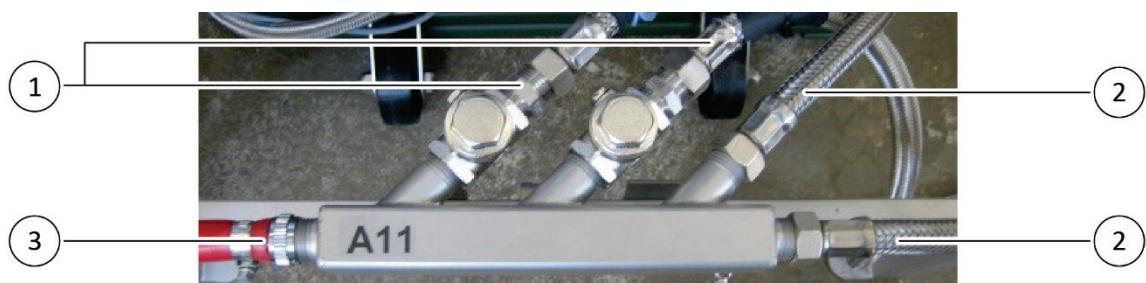
*Bild 14: Anschluss der Entsorgungsleitungen von 2 Umlaufkühlern und 2 Sterilisatoren am Sammler LSE (Draufsicht)*
